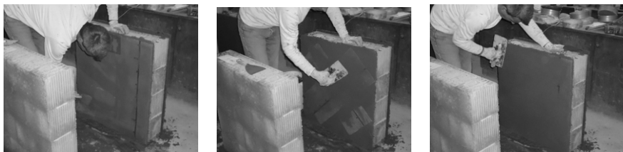
Slika 12. Ojačavanje isprskalnih zidova FRCM kompozitnim sistemom SM2 Figure 12. Strengthening of cracked walls with FRCM composite system SM2
